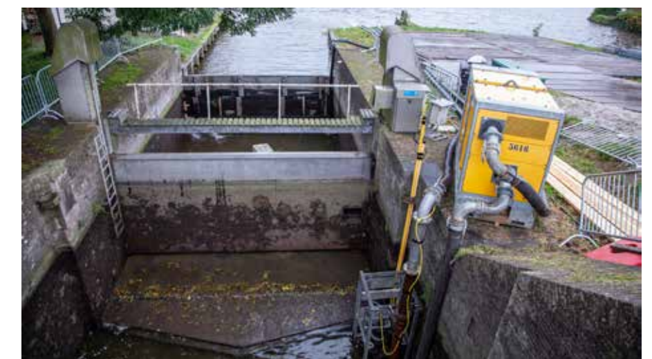
Droogzetting Zuidersluis Schardam ter voorbereiding op de versterking.
